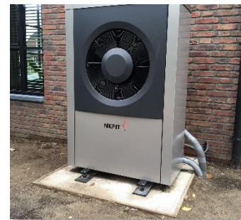
Afbeelding 2: Buitenunit bij luchtwarmtepomp
