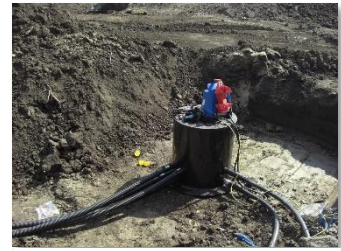
Afbeelding 4: Bron voor bodemwarmtepomp
