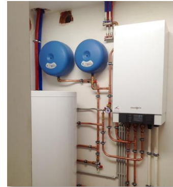
Afbeelding 1: Binnenunit bij luchtwarmtepomp
