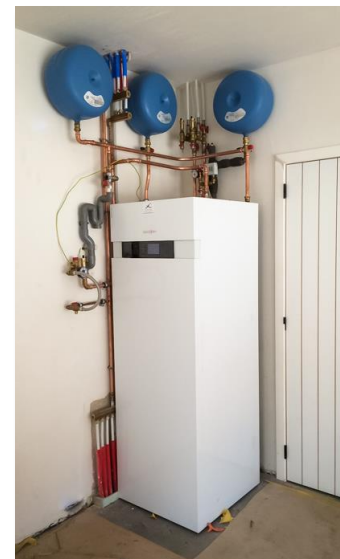
Afbeelding 3: Binnenunit bij bodemwarmtepomp
