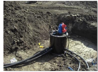
Afbeelding 4: Bron voor bodemwarmtepomp
